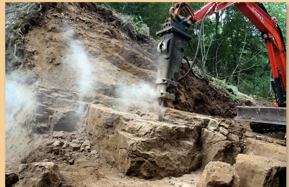
Abb. 5: Der zweite Bagger mit hydraulischem Schlagmeißel beim Abtragen der Kalkbank.
