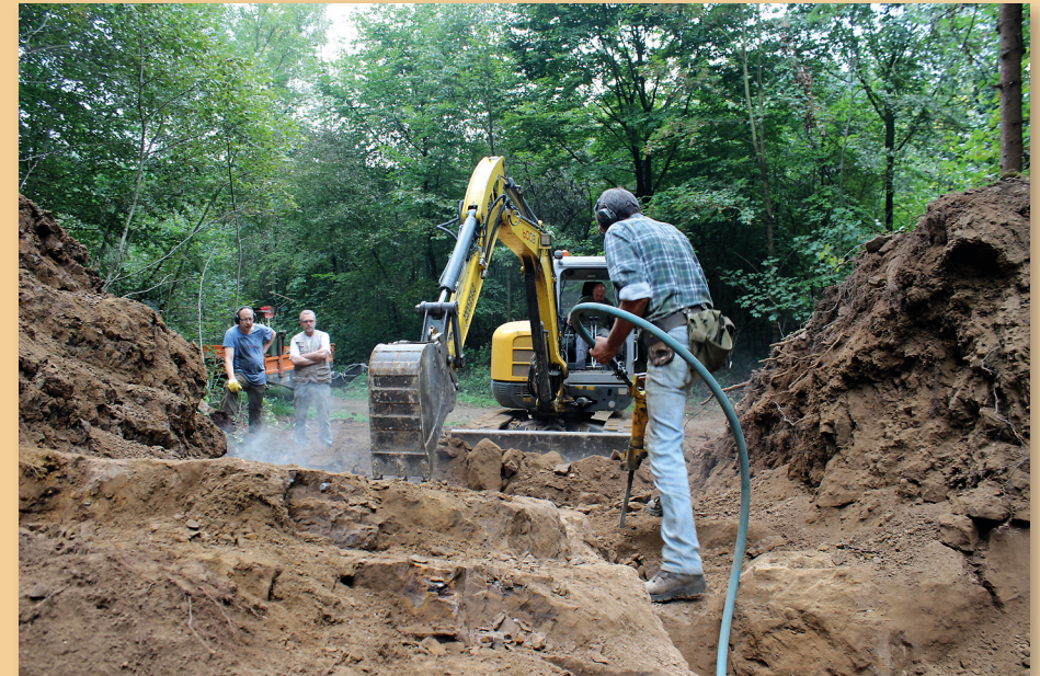
Abb. 4: Der zu Beginn eingesetzte Minibagger, wie auch der Presslufthammer kapitulieren vor der Zechsteinkalkbank.
